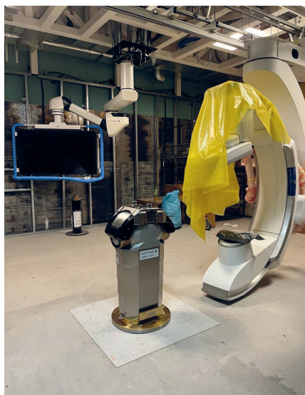
Ołowiane ściany hybrydowej sali operacyjnej i montaż angiografu. Sala hybrydowa w trakcie wyposażania
